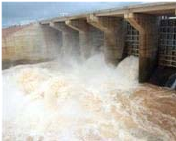
Thủy điện Trị An
