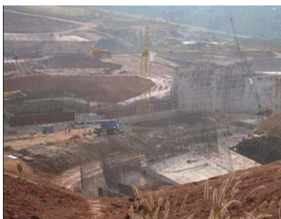
Thủy điện ĐăcRtìh
